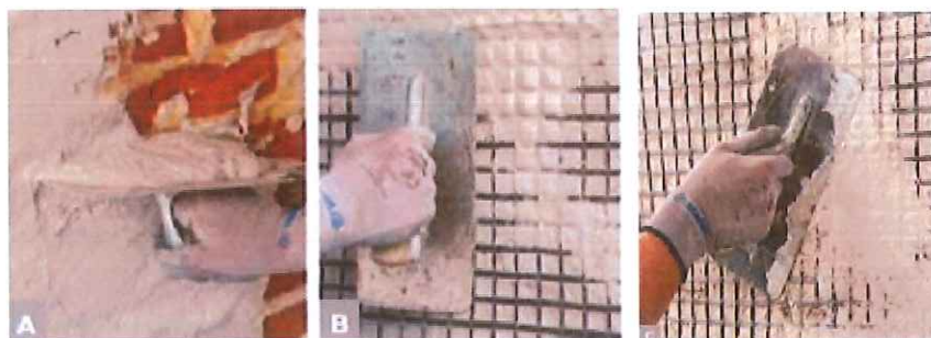
Fig. 25 – Aplicarea tencuielii armate
