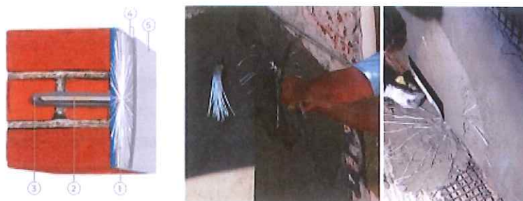
Fig. 26 – Ancorarea sistemului în câmpul pereților
