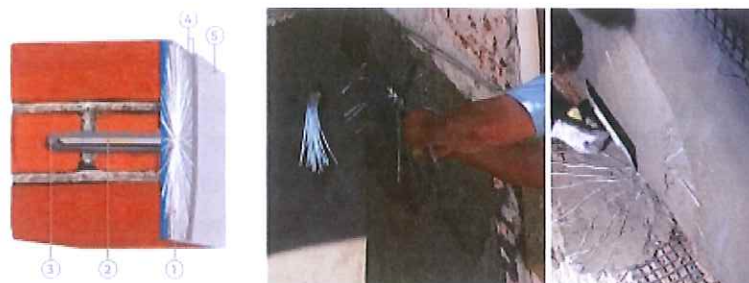
Fig. 26 – Ancorarea sistemului în câmpul pereților
