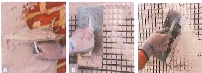
Fig. 25 – Aplicarea tencuielii armate
